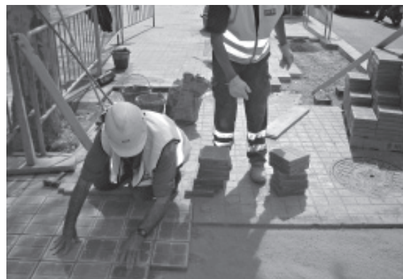
Figura 2. Trabajo en zanjas medianas
