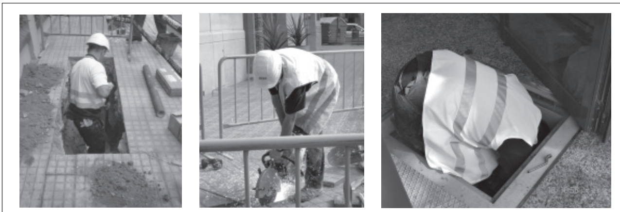
Figura. 3. Trabajo en zanjas pequeñas
